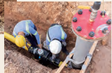
煤氣工程團隊在落馬洲方艙醫院地盤鋪設煤氣管線。
