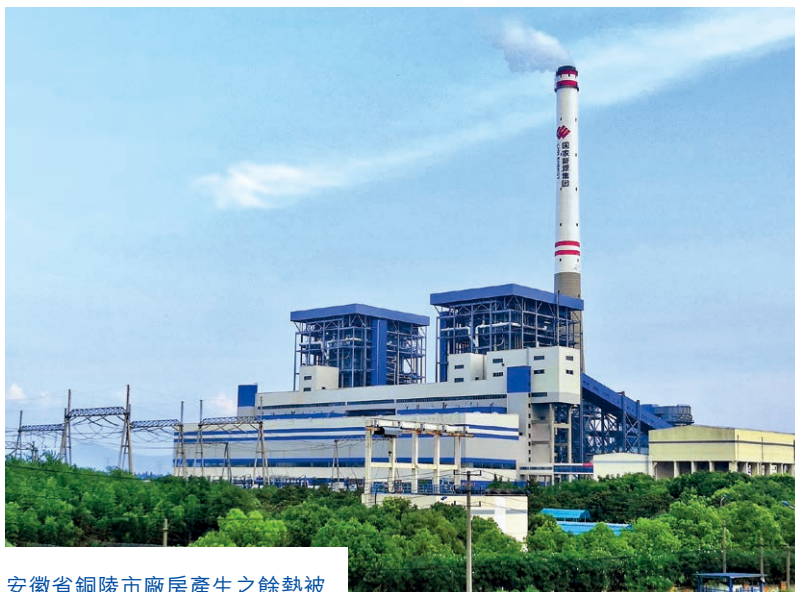
安徽省銅陵市廠房產生之餘熱被轉化成能源，供工業客戶使用。
